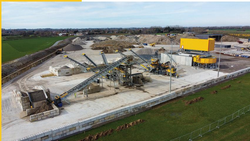
Création d'une unité de lavage de déblais terreux, permettant de valoriser les produits d'excavation et de déconstruction en gravillons et sable propres.
